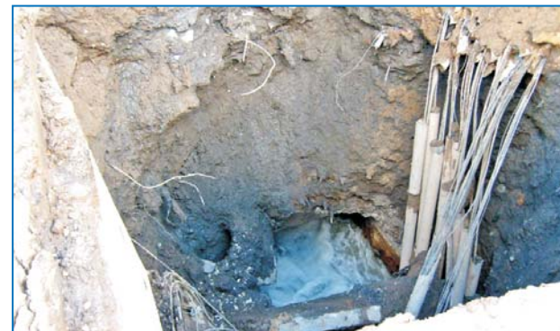
Разрушение свода канала
