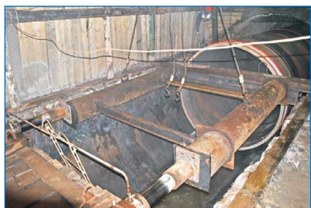
Проталкивание стеклопластиковой трубы
