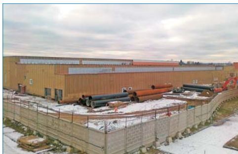
Строительство блока очистных сооружений № 2 (320 тыс.куб.м/сут.)
