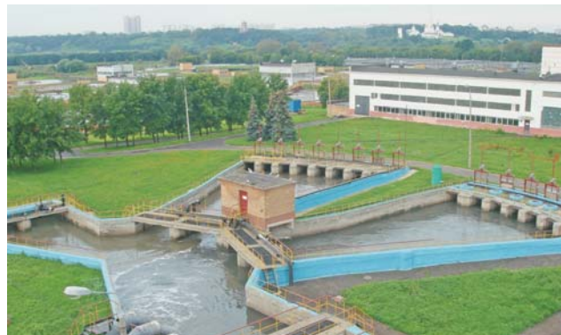
Приемно-распределительная камера
