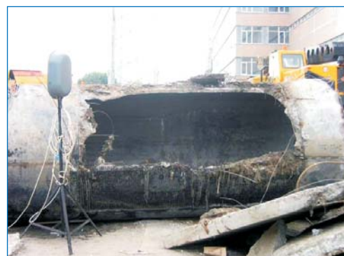
Авария на канализационном трубопроводе Д-1600 мм (железобетон), Новобатунинская ул.
