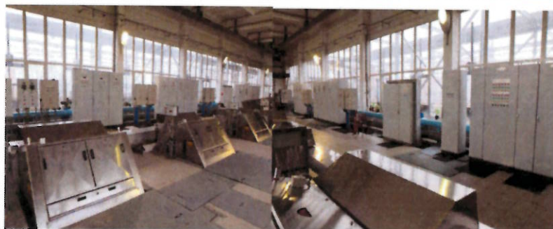
Автоматизированная система диспетчерского контроля и управления решетками и песколовками
