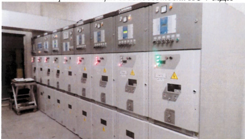
Северная станция водоподготовки НС-7 КРУ-6кВ
