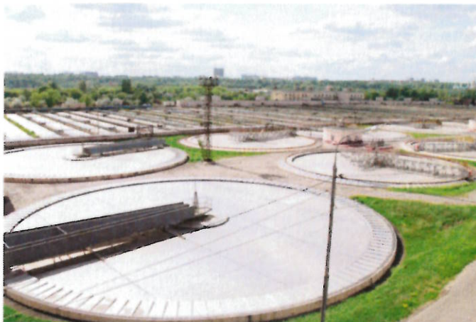
Уникальные плавающие перекрытия на первичных отстойниках старого блока Курьяновских очистных сооружений
