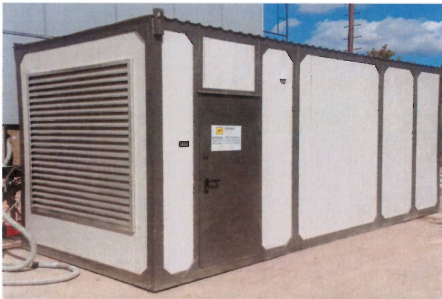
КНС Ново-Солнцевская дизельная электростанция мощностью 600 кВт
