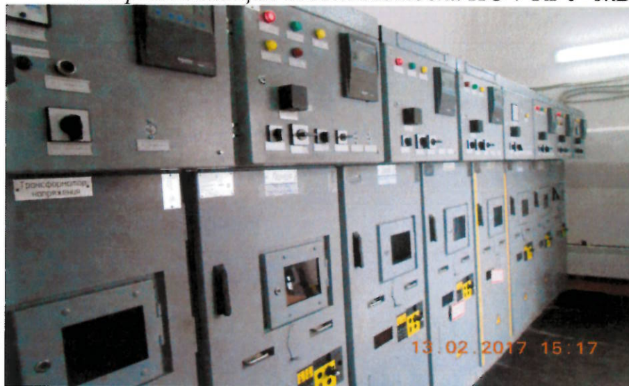
Северная станция водоподготовки НС-7 КРУ-6кВ
