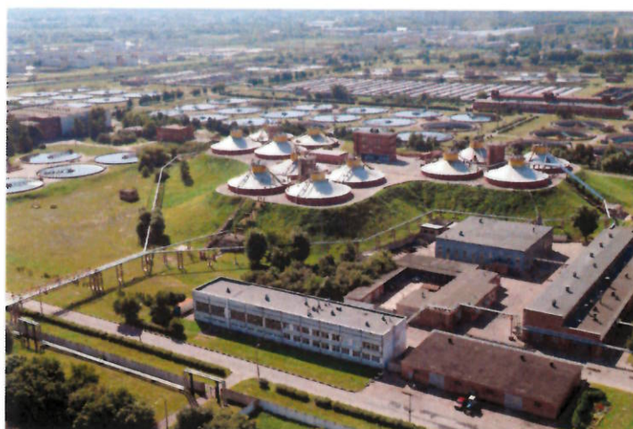
Метантенки на Люберецких очистных сооружениях
